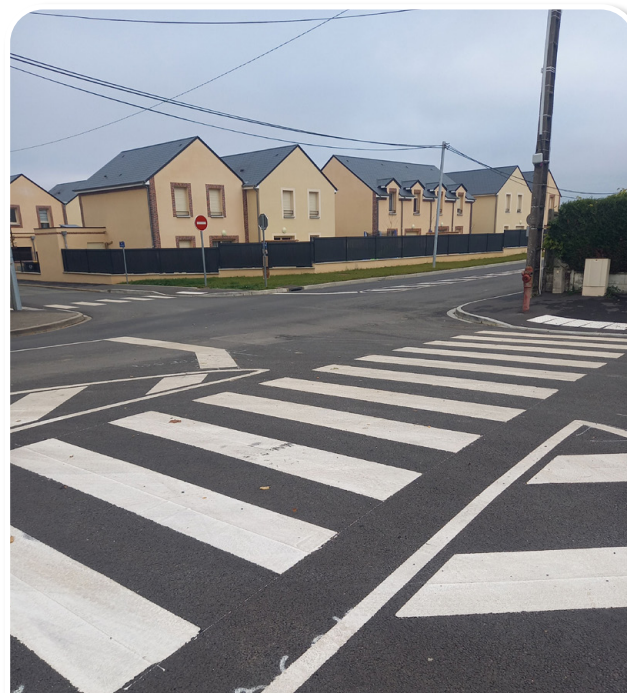
Aménagement du carrefour de la rue des 3 Marie et la rue de Brémont avec implantation de passages piétons et amélioration de la giration pour les véhicules notamment les bus scolaires.
